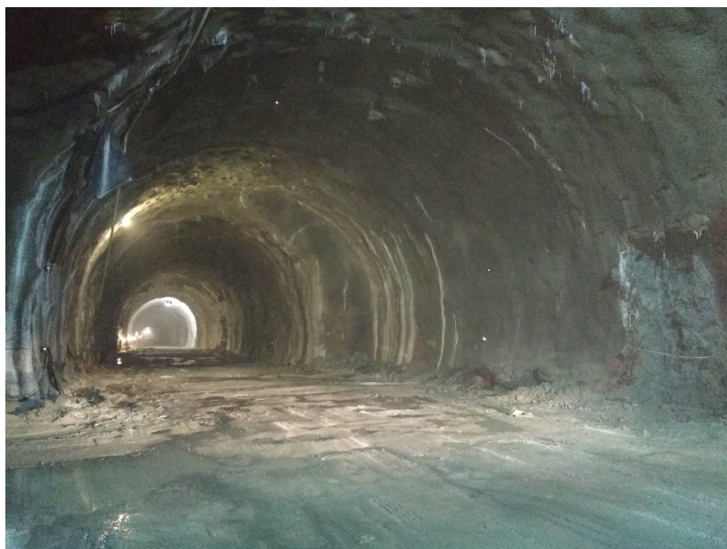
Obr.9 NZ 6 JTR – nezastriekaný výklenok prítok vody zo stropu
