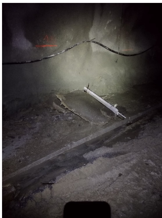
Obr.4 S367 – vypadnutý betón zo stropu
