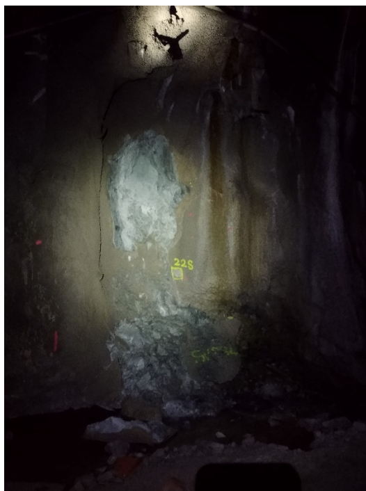
Obr.10 S 334 – Prítok vody, porušený výklenok
